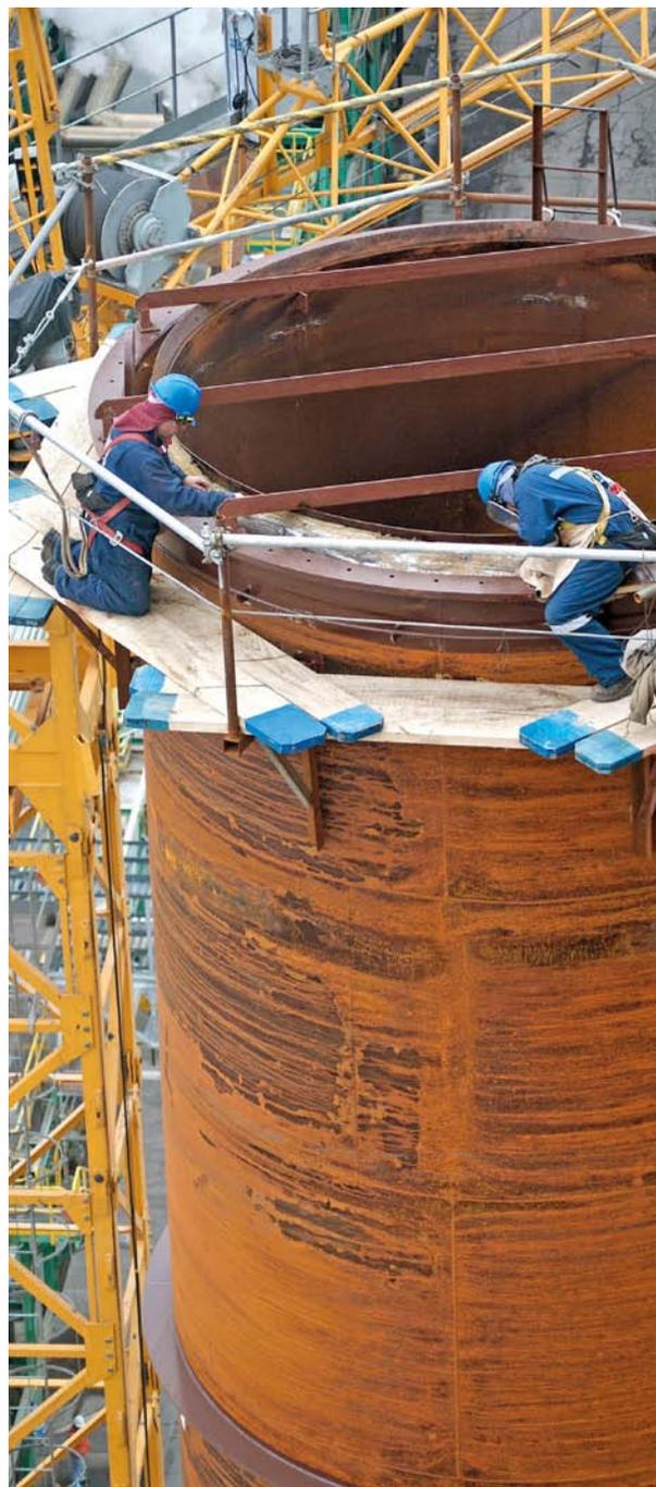
*Montaje de la chimenea de nueva caldera recuperadora en Planta de Celulosa Laja.*
