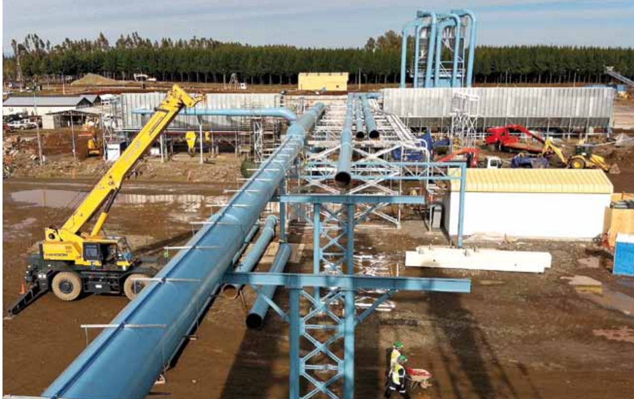
Trabajo de contratistas especializados en el montaje del sistema de extracción, filtrado y manejo de partículas de madera, astillas y finos de máquinas lijadoras, correspondiente a la ampliación de la Planta Plywood (paneles contrachapados), localizada en Mininco, comuna de Collipulli, Región de la Araucanía.
