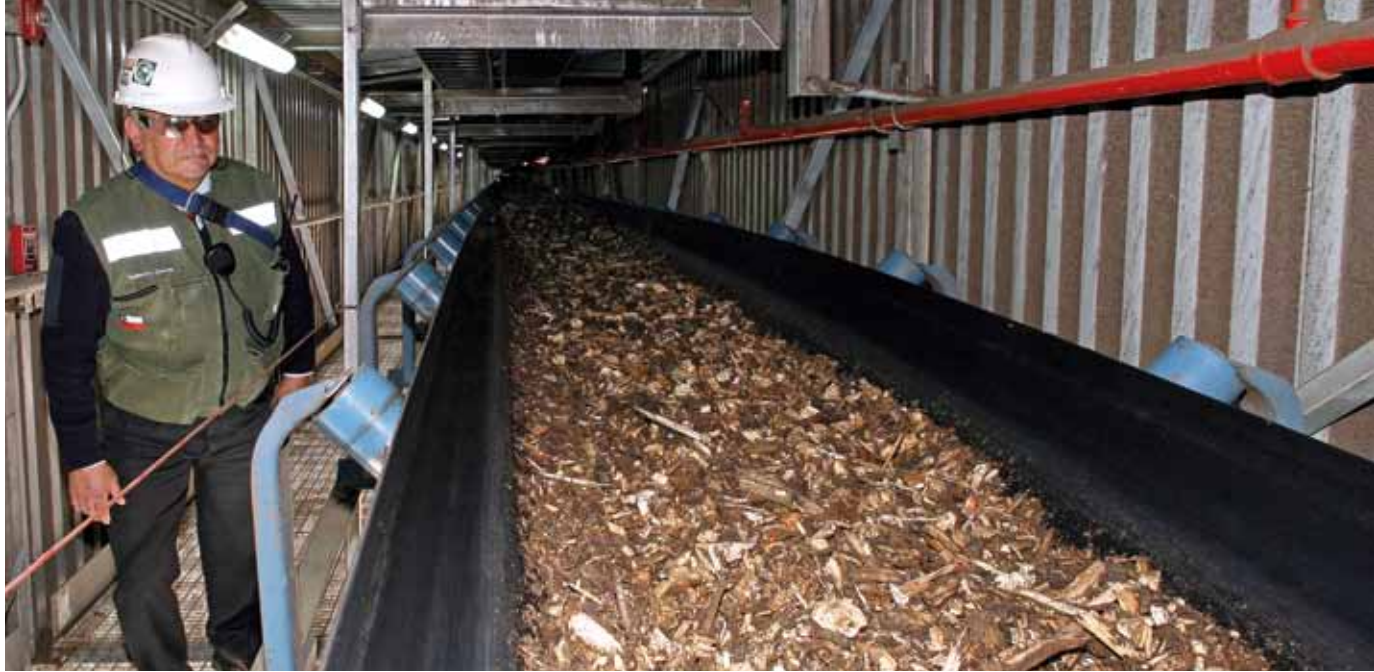
> Mezcla de biomasa transportada por correa a la caldera.
