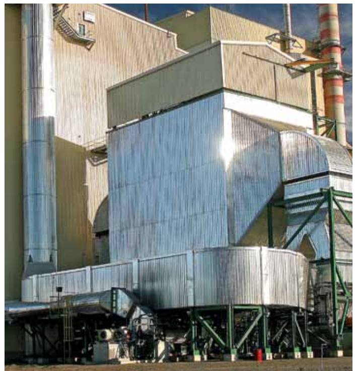
Precipitador electrostático de partículas en caldera de biomasa de Planta Santa Fe.
