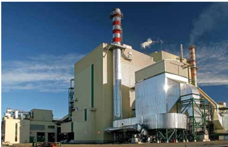
> Caldera de biomasa dotada de precipitador electrostático de partículas.
