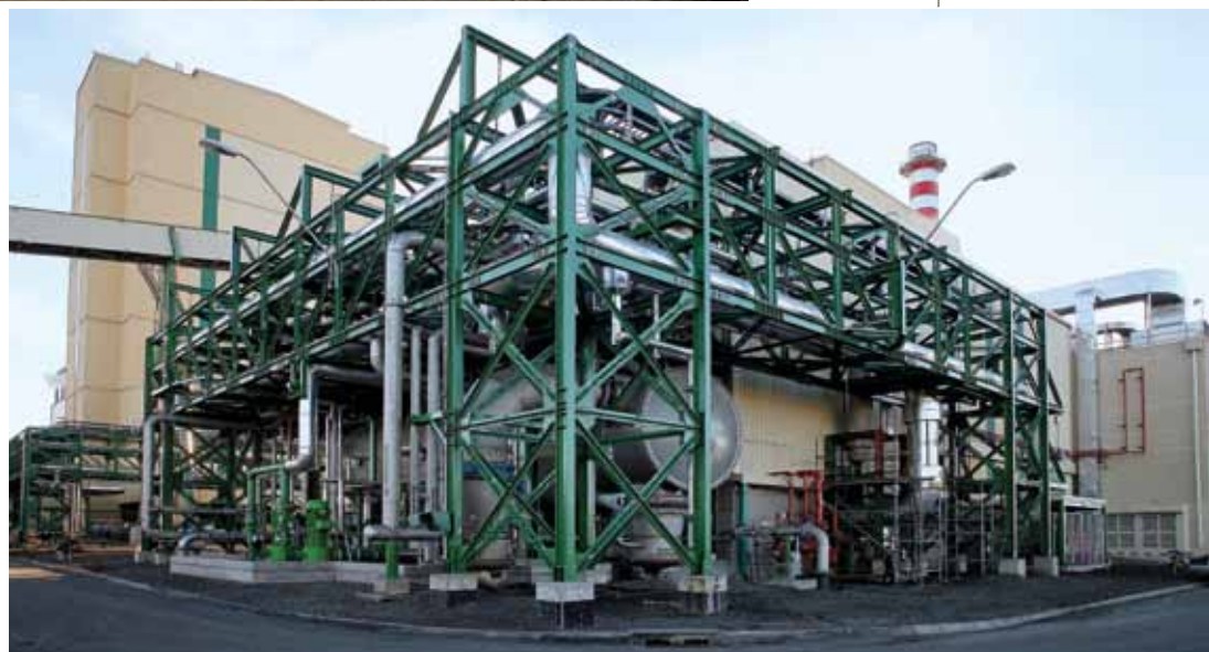
> Caldera de biomasa dotada de precipitador electrostático de partículas.
